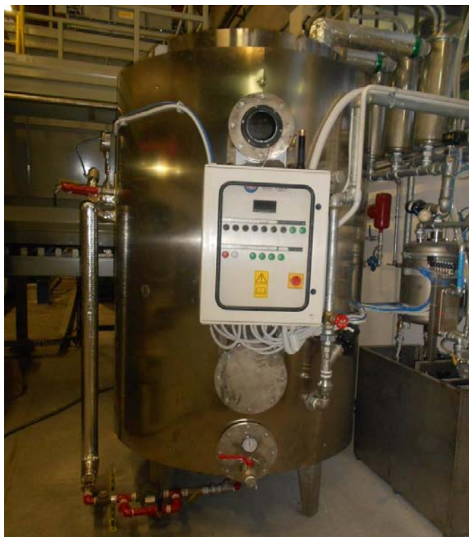
Fig.9 Foto dell'evaporatore installato
