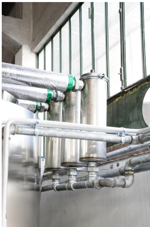
Particolare delle unità di condensazione installate. La fotografia riproduce la macchina installata presso il cliente.
