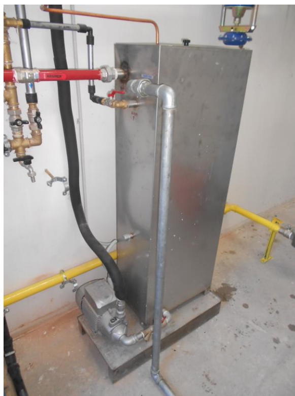
Fig.2 Foto del serbatoio di raccolta delle condense
