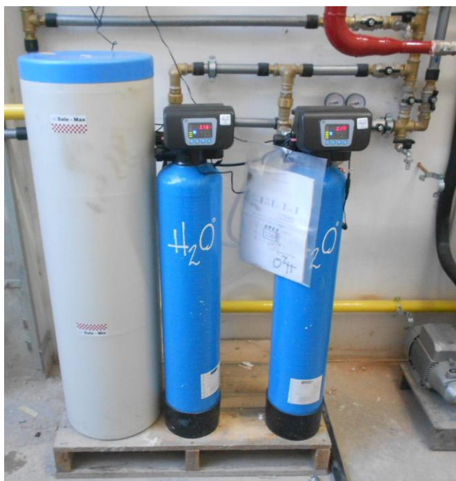
Fig.6 Foto dell'impianto di addolcimento
