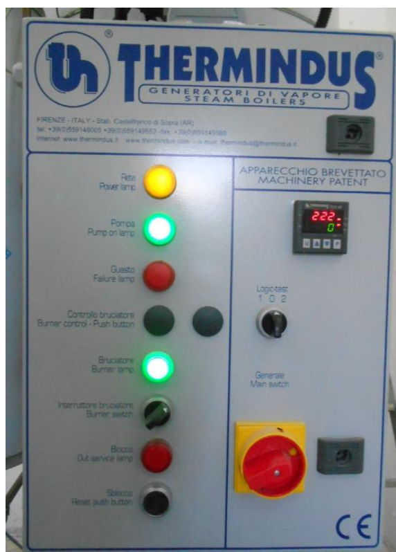
Fig.8 Pannello di controllo del generatore di vapore
